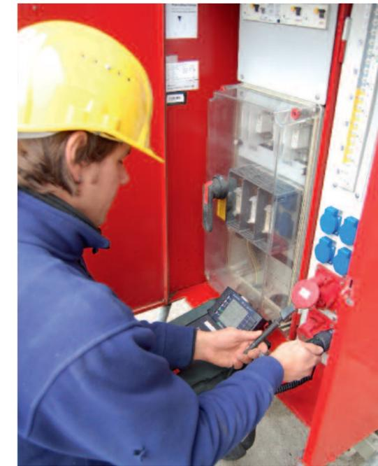
Inbetriebnahmeprüfung eines Baustromverteilers entsprechend der VDE 0100-600
