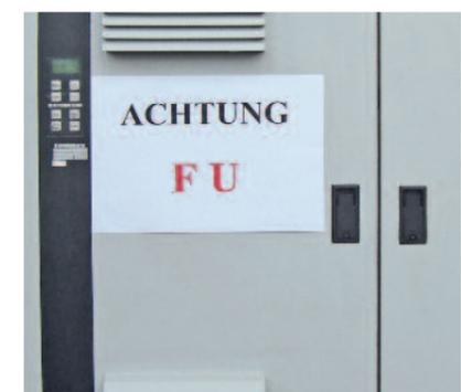
Beispiel für die Kennzeichnung eines frequenzgesteuerten Krans
